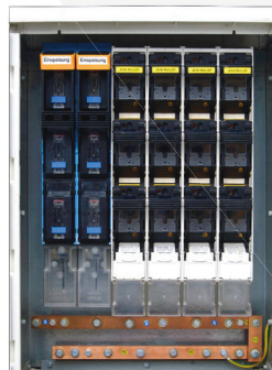
Energieverteiler 1.000 A
